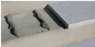
**i** Evo-Abdeckplatten immer auf Klebändern verlegen um temperaturbedingte Spannungen auszugleichen (Auftreten von Spannungsrissen). Alle Stoßfugen sind mit Dehnfuge elastisch auszubilden, ebenso alle Anschlussfugen.
