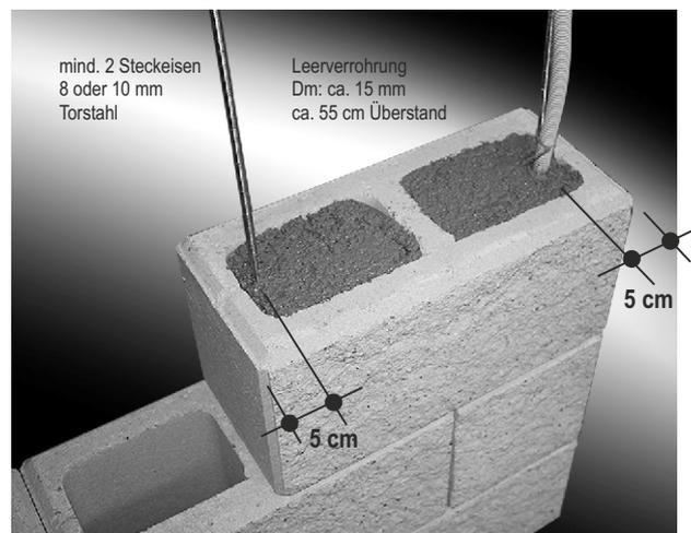
Aufbau mit Dichtkleber und ausbetonieren des Mauerwerkes bis zur Unterkante des geplanten Briefkastens. Wichtig: Spätestens jetzt müssen Steckseisen und Leerverrohrung in der richtigen Position sein.
