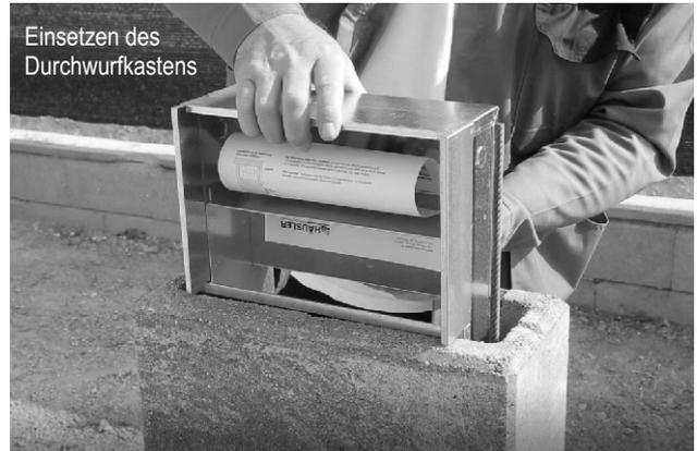
2. Das Einsetzen des komplett zusammengebauten Briefkastens (inkl. Frontplatte und Entnahmetüre) erleichtert die genaue Justierung. Leerverrohrungen legen.
