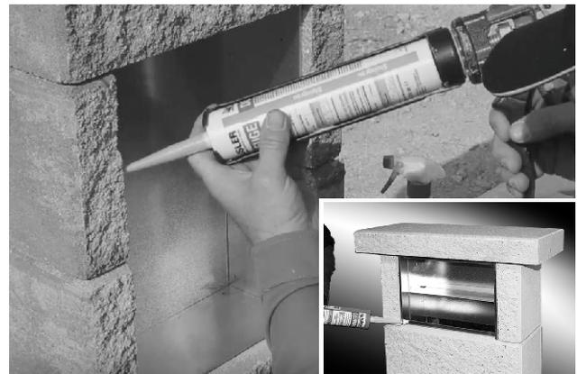
6. Frontplatte und Entnahmetür ausbauen. Alle offenen Fugen mit Häusler-Dehnfuge abdichten. Frontplatte und Entnahmetür wieder einbauen.
