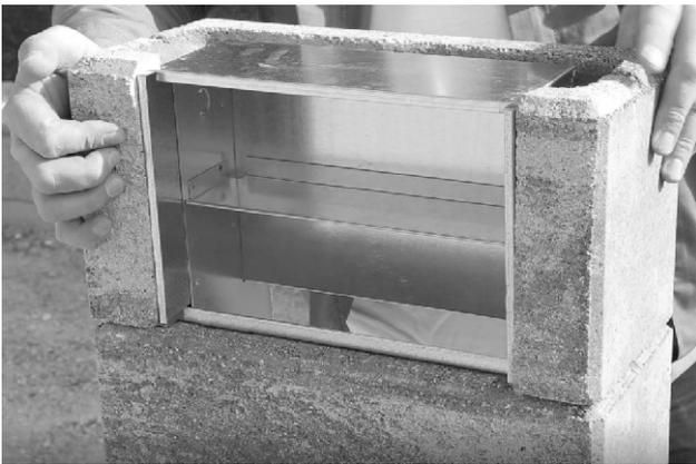
3. Obersten, zugeschnitten Stein mit Dichtkleber aufsetzen. Briefkasten einrichten und mit Keilen fixieren. Die Frontplatte und die Entnahmetüre auf Freigängigkeit prüfen.
