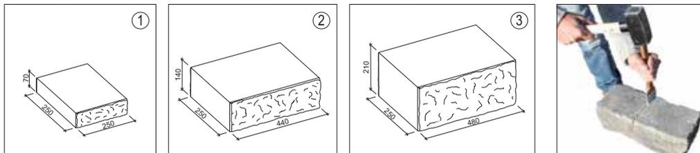
Mit einem Breitmeißel können Sie die Steine einfach auf das von Ihnen gewünschte Maß selbst brechen - zum Beispiel für Anfang- oder für Endsteine, oder für Steine auf Maß. Eine mit dem Winkelschleifer vorge-schnittene „Sollbruchstelle“ erleichtert diesen Brechvorgang
