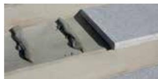
**i** Stufenplatten in LeichtRein-Oberflächen immer auf Mörtelbändern verlegen um temperaturbedingte Spannungen auszugleichen (Auftreten von Spannungsrisen). Alle Stoßfugen sind mit Dehnfuge elastisch auszubilden, ebenso alle Anschlussfugen.
