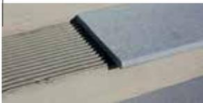
**i** Poolrandplatten in Naturstein-Oberflächen immer vollflächig mit Zahnspachtel (Zahnung 10 mm) verlegen. Alle Stoßfugen sind mit Dehnfuge elastisch auszubilden, ebenso alle Anschlussfugen.
