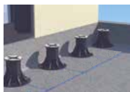
Stelzlager Basic mit Kreuzkopf im richtigen Abstand aufstellen
