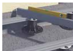
Mit Wasserwaage die waag-rechte prüfen und die Stelzlager dementsprechend verstellen.
